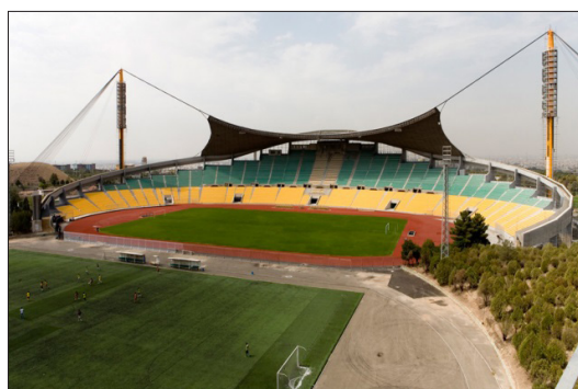
شکل ۳. استادیوم تختی تهران و سازه کابلی منحصر بفردش؛ ماخذ: آرشیو نگارنده.
