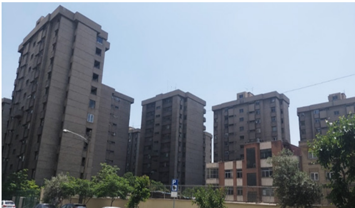
(شکل ۱) - مجتمع مسکونی بهجت آباد
