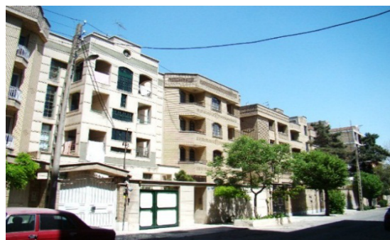
تصویر ۴. بالکن‌های اجرا شده در پخ ۴۵ درجه
